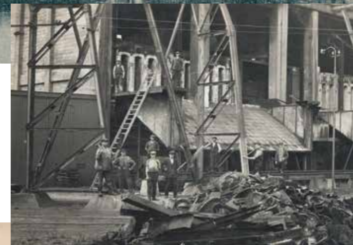
Huta Ferrum, stalownia, 1936 (włas. MHK)
