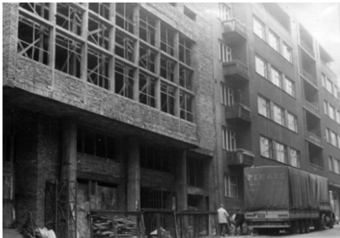
Budowa domu wspólnotowego, lata 80. XX wieku
